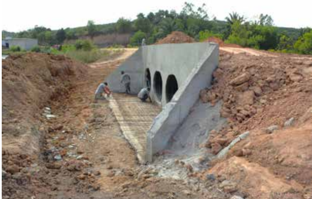
A obra já está em fase final e, em breve, os moradores da região poderão se deslocar com mais tranquilidade e segurança na região.
