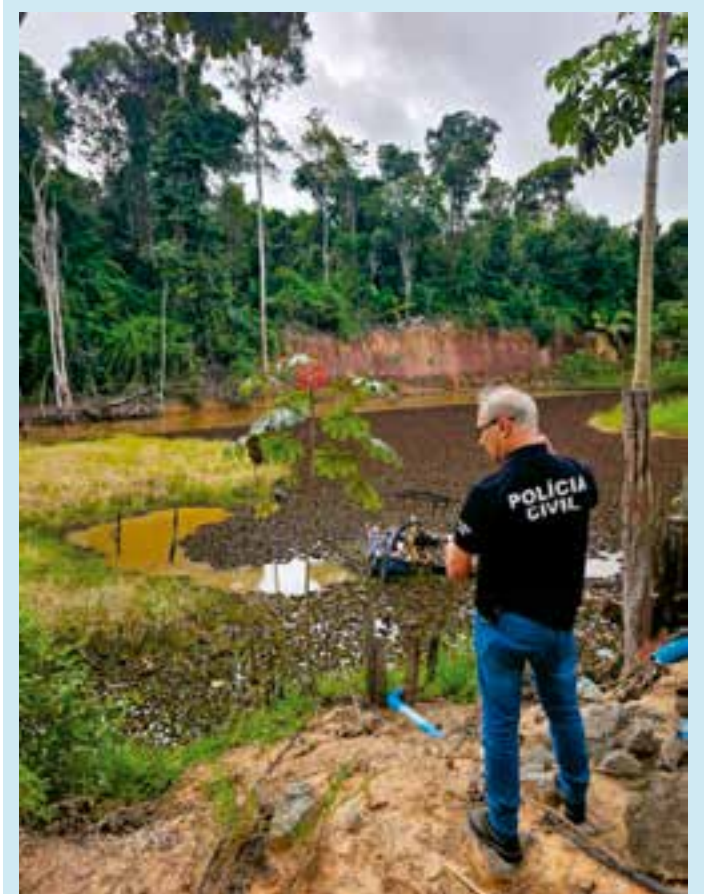
Durante a ação, foi identificada uma ligação direta trifásica à rede da concessionária, sem a presença de medidor, abastecendo uma bomba de irrigação de 10 CV utilizada no cultivo da propriedade.
