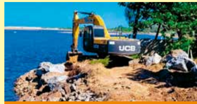
Mais de 750 toneladas de pedras foram colocadas entre o mar e o rio; moradores aguardam obra definitiva com apoio dos governos estadual e federal.
