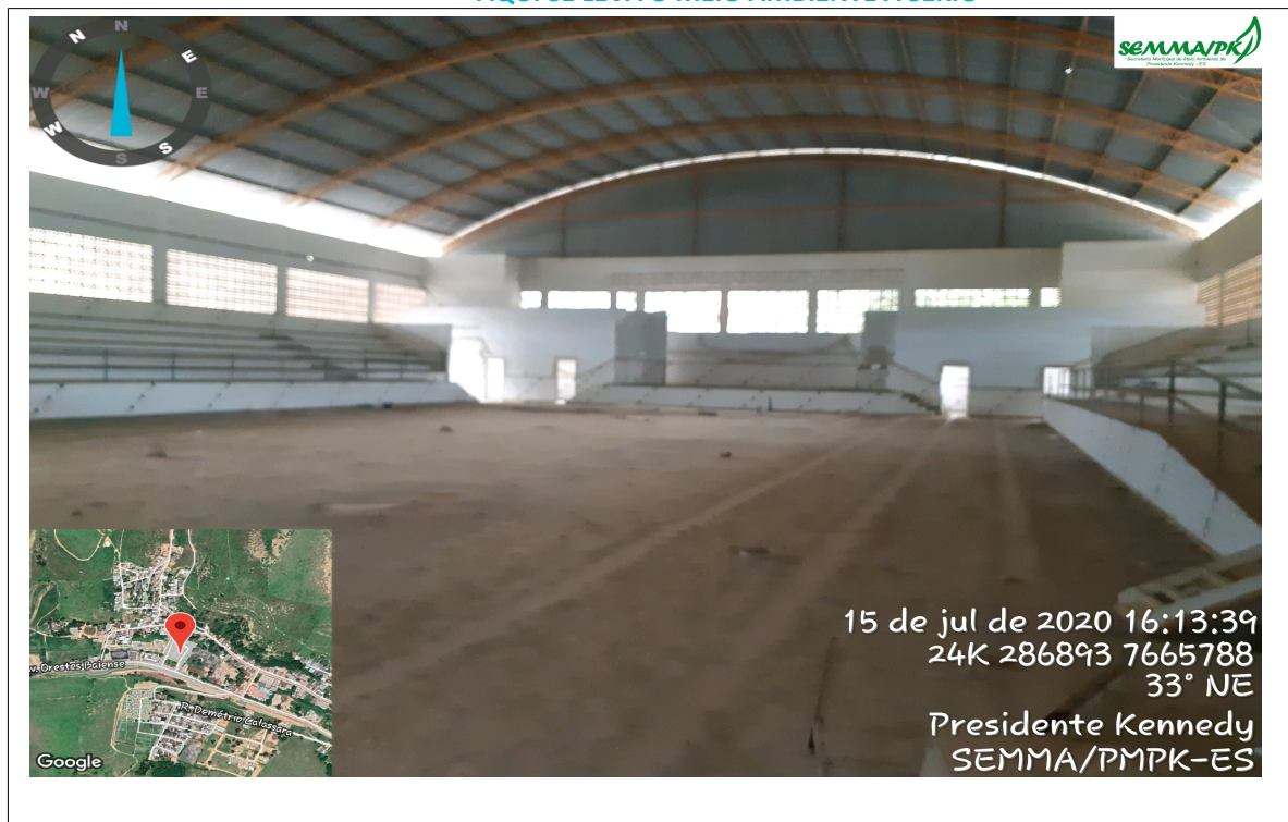
FOTO 05: Vista interna do Ginásio Poliesportivo Eraldo Correa Lemos (Correão).
